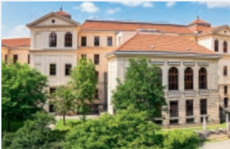
Campus Nord Hasnerplatz Altbau
