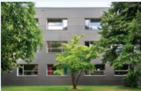
Campus Nord Hasnerplatz Neubau
