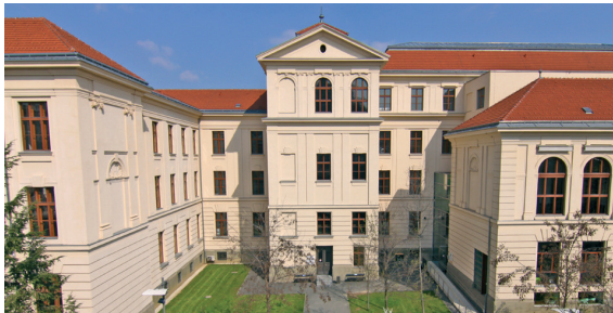
Hasnerplatz Altbau Hasnerplatz 12, 8010 Graz Gebäudekürzel: A
