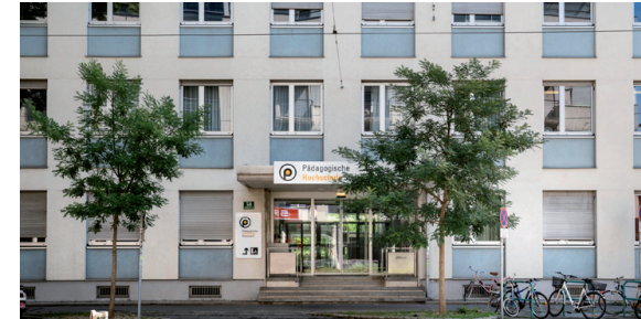
Theodor-Körner-Straße Theodor-Körner-Straße 38, 8010 Graz Gebäudekürzel: T
