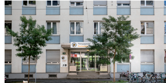
Theodor-Körner-Straße Theodor-Körner-Straße 38, 8010 Graz Gebäudekürzel: T
