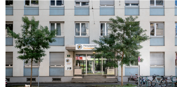
Theodor-Körner-Straße Theodor-Körner-Straße 38, 8010 Graz Gebäudekürzel: T
