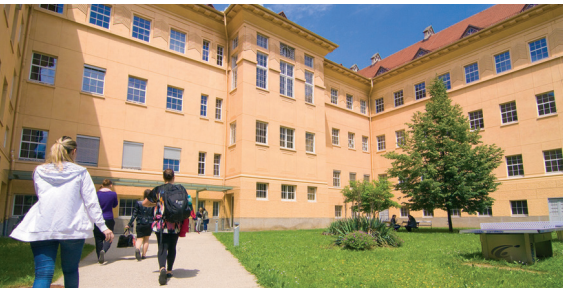
Ortweinplatz Ortweinplatz 1, 8010 Graz Gebäudekürzel: O
