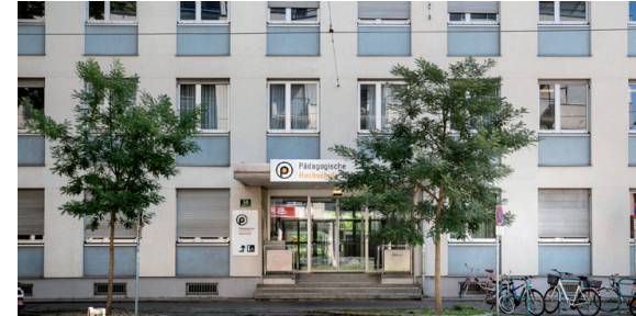
Theodor-Körner-Straße Theodor-Körner-Straße 38, 8010 Graz Gebäudekürzel: T
