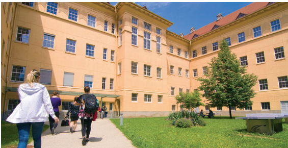
Ortweinplatz Ortweinplatz 1, 8010 Graz Gebäudekürzel: O
